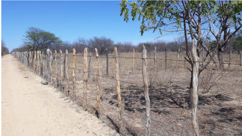
Cerca perimetral com 8 fios de arame farpado
