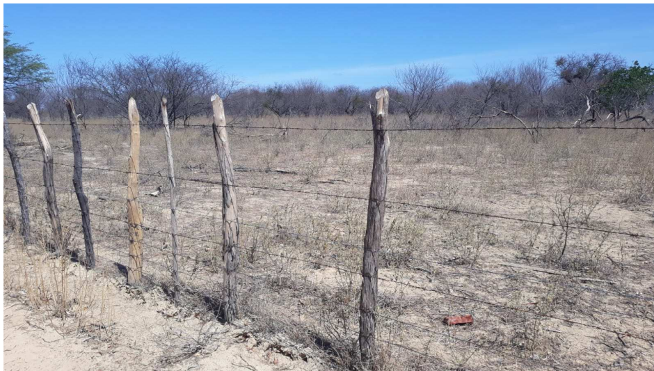
Cerca perimetral com 8 fios de arame farpado
