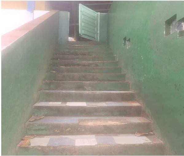
Foto da escada
